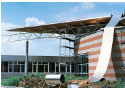
Kręgi blachy stalowej są cięte na placu budowy do wymaganej wielkości.
