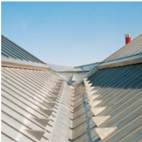
Pokrycia wentylacyjne w zagłębionych rynnach zapewniają wentylowanie konstrukcji dachowej.
